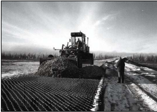
Rys. 8. Zасыpywanie kruszywem komórek geosiatki za pomocą ładowarki
