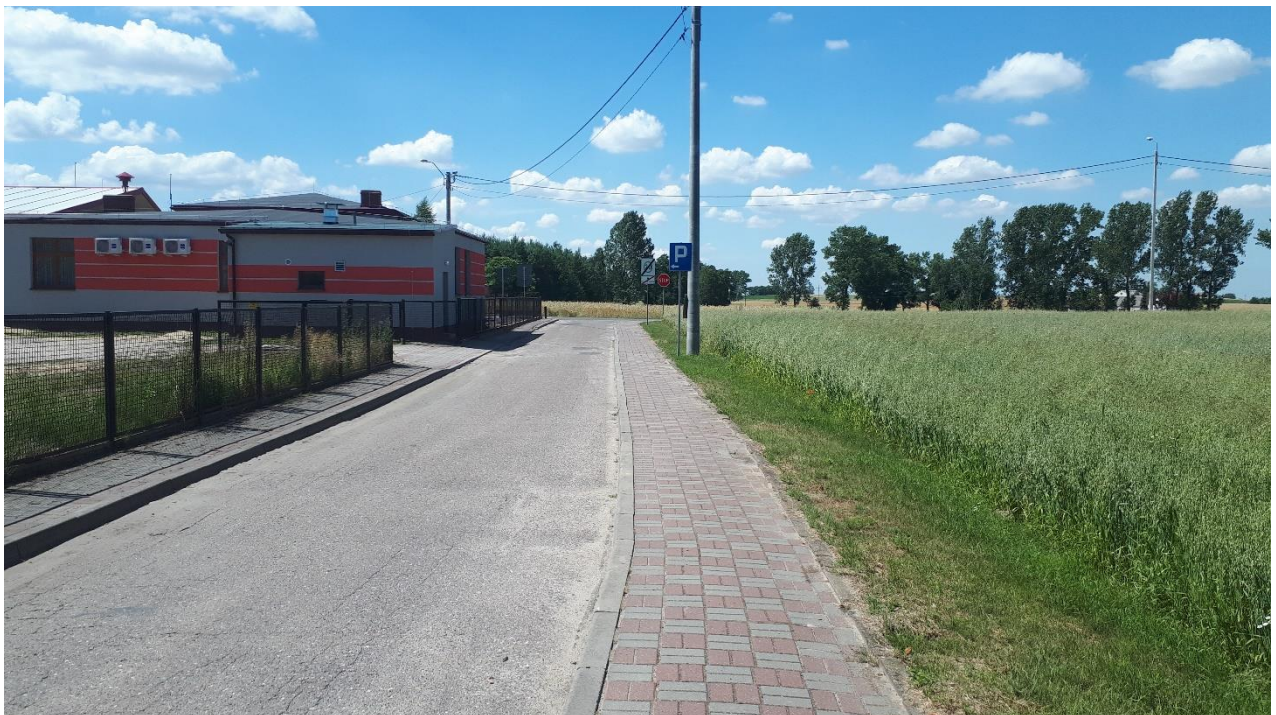
Zdjęcie nr 1. Droga wewnętrzna w miejscowości Błenna - stan istniejący
