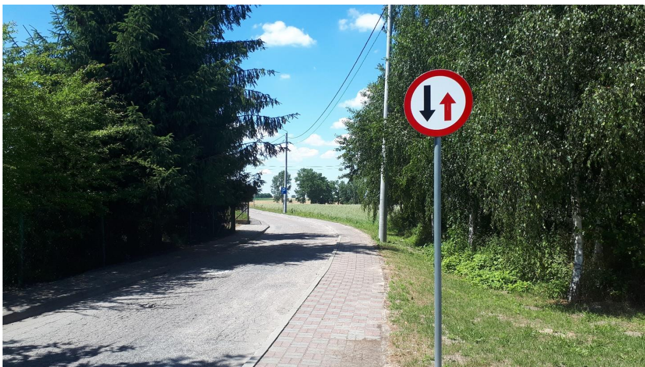
Zdjęcie nr 2. Droga wewnętrzna w miejscowości Błenna - stan istniejący
