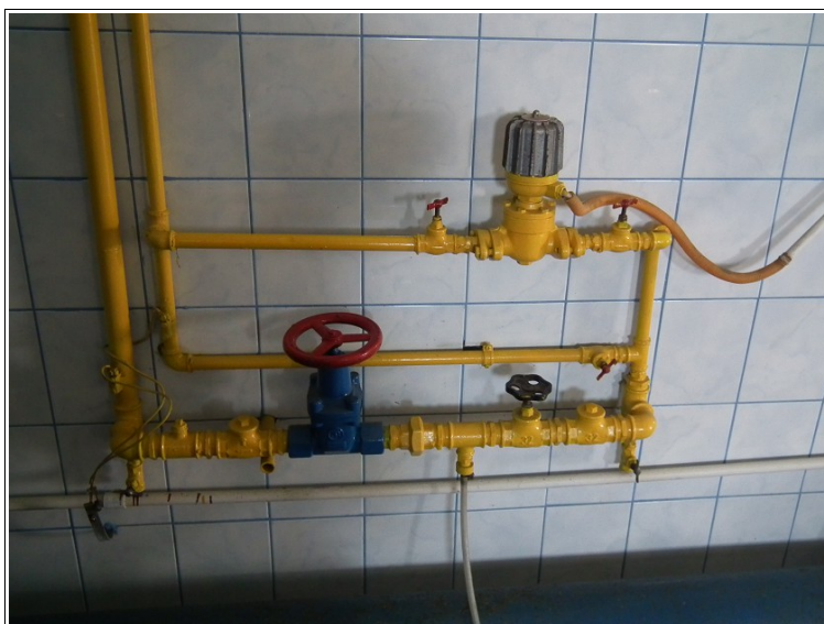
Zdjęcie 3. Węzeł sprężonego powietrza
