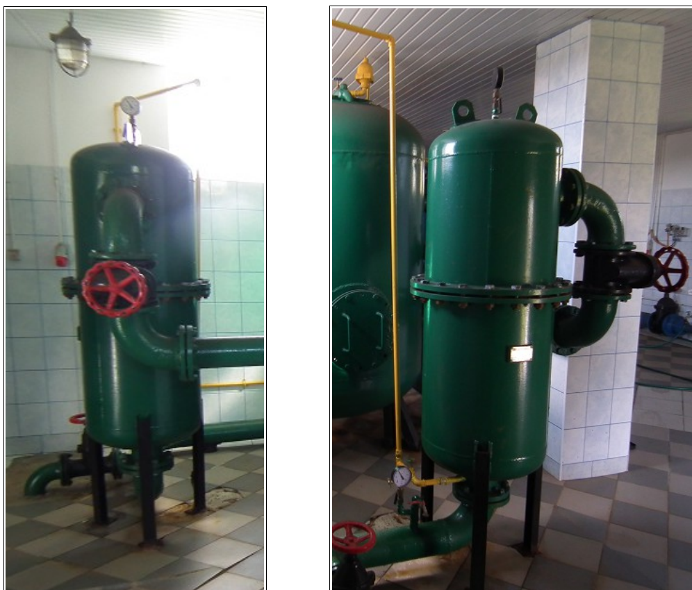
Zdjęcie 1. Aerator do napowietrzania ciśnieniowego
